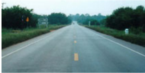
รูป : แสดงทางหลวงสาย 229 ที่ตัดผ่านหมู่บ้าน
